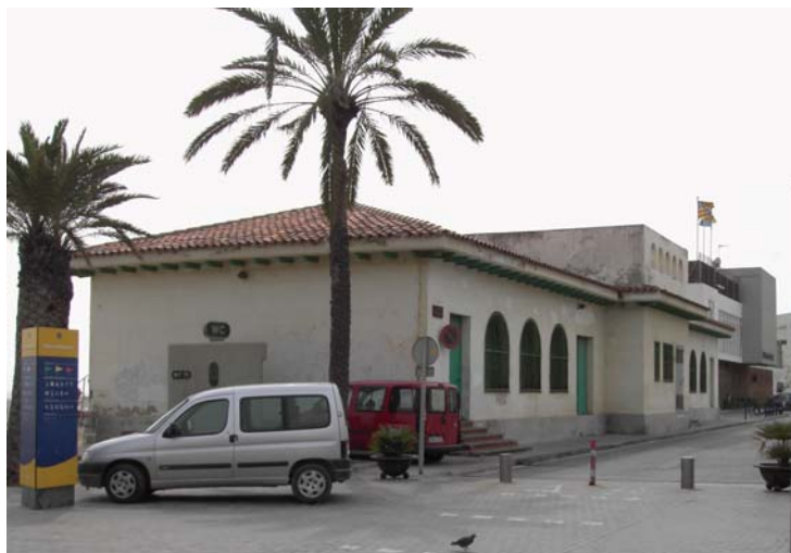
Figura 6. Edifici que actualment acull la llotja de Badalona. Font: pròpia.
