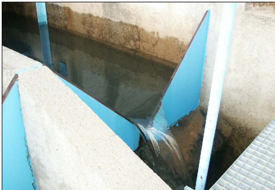
Fotografia 5.1.1. Sobreexidor triangular de llavi prim emprat per regular el cabal.
