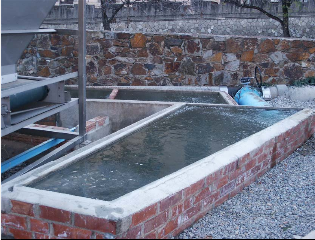
Fotografia A.1. Cambra d'entrada d'aigua connectada al canal.
