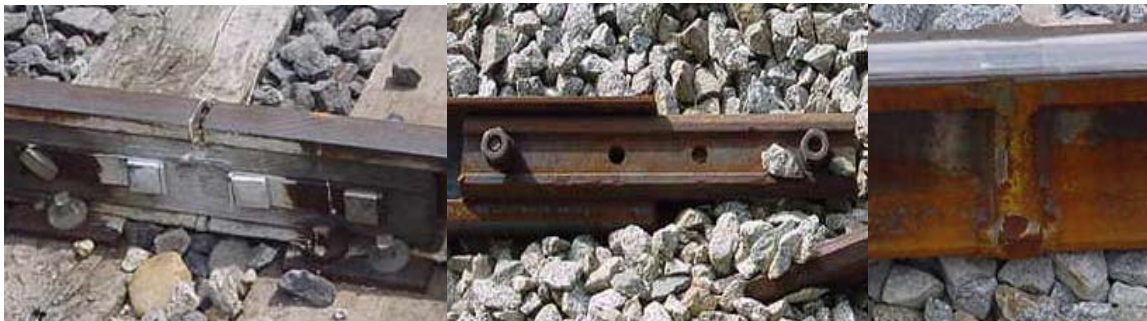
Imagen 1.6, 1.7 y 1.8.- Unión mediante brida de madera, brida metálica y soldadura aluminotérmica.
