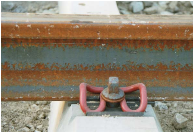
Foto 1.5.- Sujeción elástica de carril.
