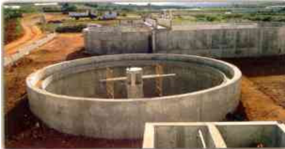
Figura 7.1. Depósito de hormigón armado de una EDAR en construcción
