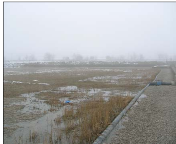
Fig. 3.2 Fenomen de la colmatació a l'entrada dels aiguamolls de recepció de l'EDAR de Verdú
