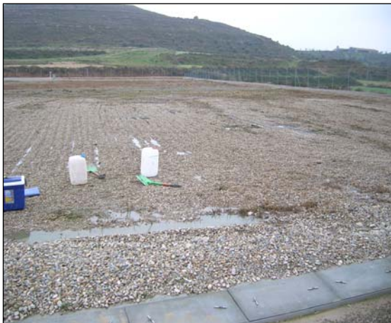
Fig. 3.1 Presència d'aigua superficial al principi de l'aiguamoll de recepció de l'aigua residual de l'EDAR d'Alfés
