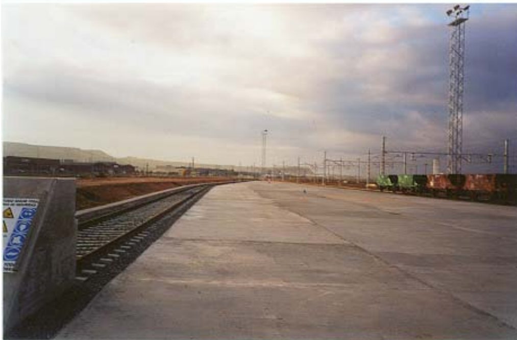
Playa de vías existentes en el Polígono Industrial El Sequero
