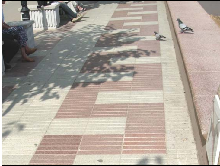
Fotografía 8. Decorado del pavimento. Paseo marítimo de Tossa de Mar
