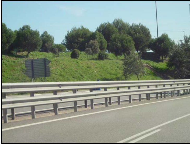
Fotografía 90. Talud en la carretera C-16
