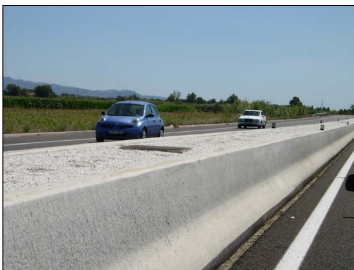
Fotografía 87. Mediana en la carretera C-260
