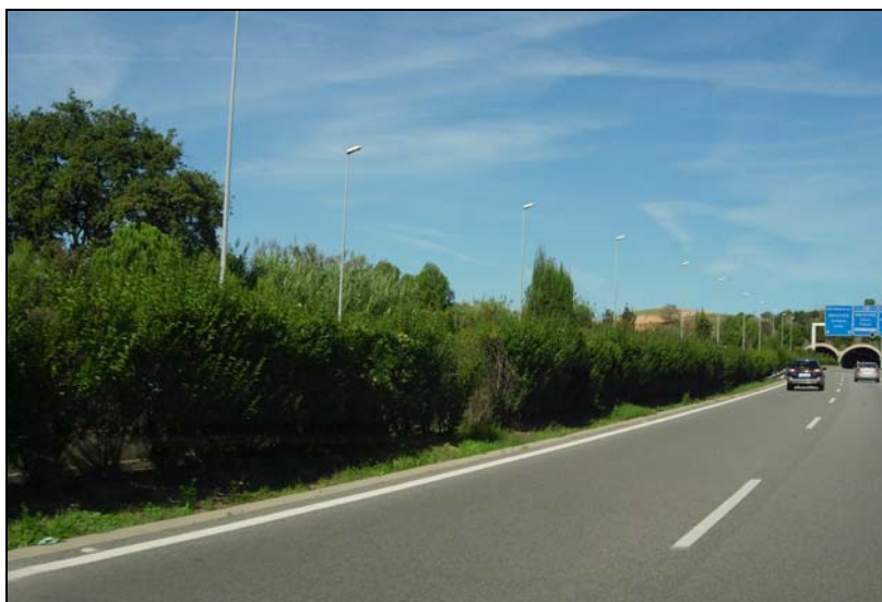
Fotografía 86. Mediana de la carretera C-16
