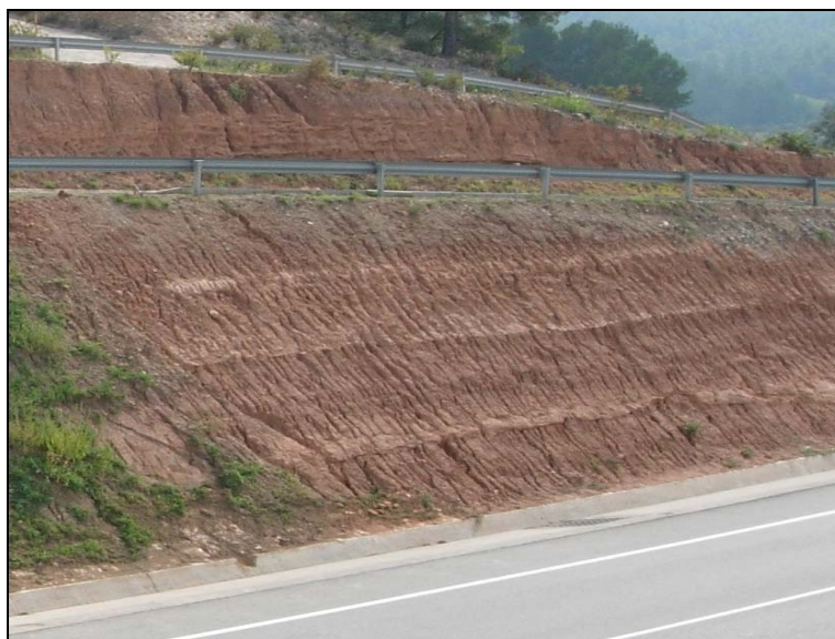
Fotografía 92. Talud en la carretera C-15
