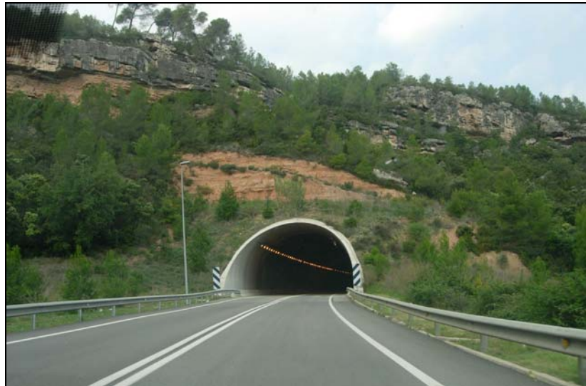
Fotografía 88. Entrada integrada de un túnel en la carretera C-15
