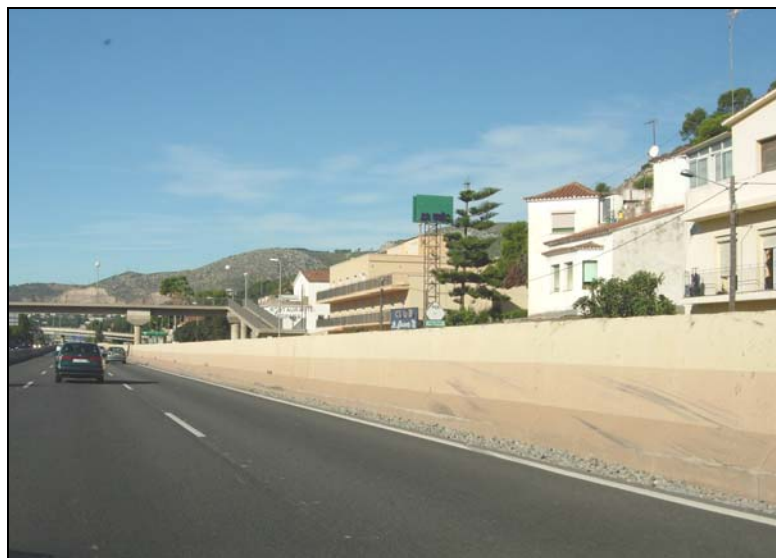
Fotografía 85. Barrera acústica en Castelldefels
