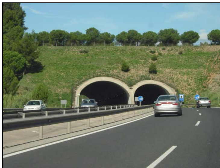
Fotografía 89. Falso túnel en la carretera C-16
