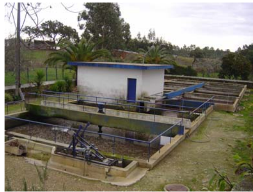
Fotografía 8. Vista de la EDAR de S.Luís.
