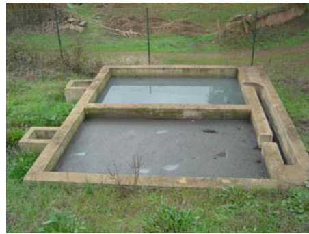
Fotografía 10. Laguna facultativa y lagunas de deshidratación de fangos de Vale Ferro (a la izquierda y derecha respectivamente)
