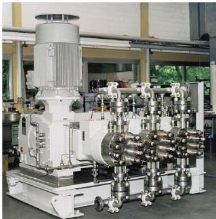
Figura M.4- Bomba Lewa de diafragma amb triple capçal.
