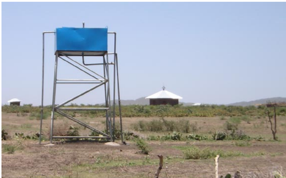
figura b.13 Els tanc elevats són una solució en zones planes
