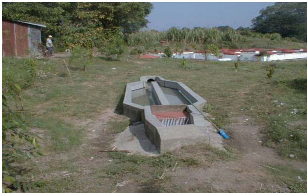
figura b.11 Exemple de tanc de sedimentació.
