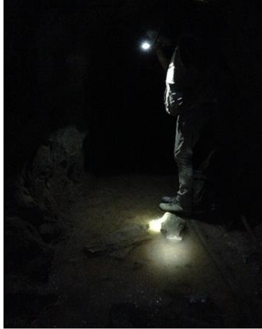
Figura 26. Galeria inundada amb eslleivissades de roques
