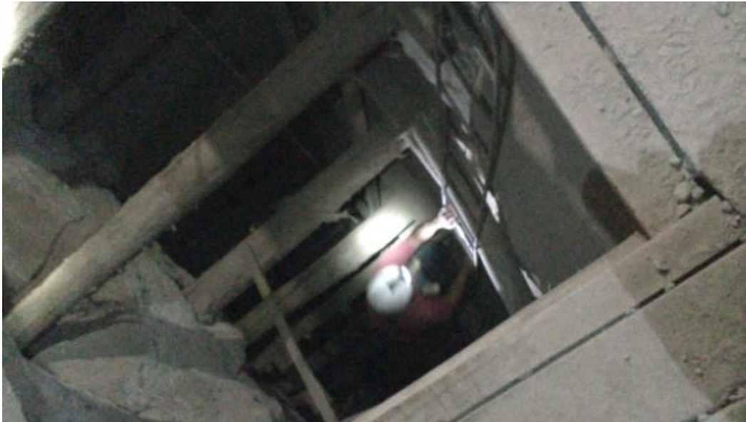
Figura 23. Pou pujant un treballador per l'escala
