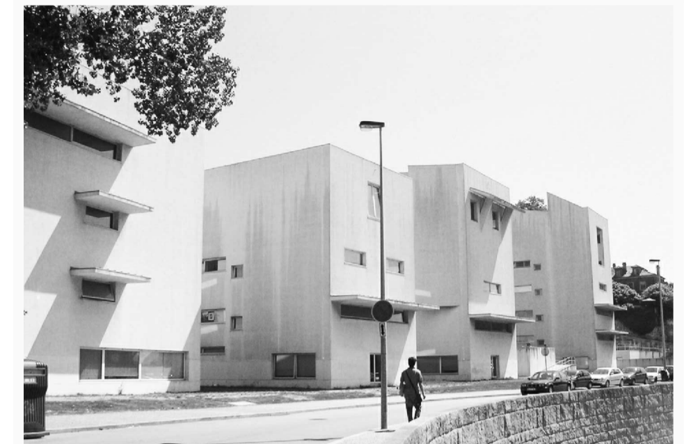
FACULDADE DE ARQUITECTURA, PORTO, ALVARO SIZA
