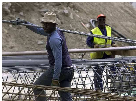
Imagen 2.1 Inmigrantes trabajando en la construcción Fuente: www.elpais.com Foto: Santos Cirilo
