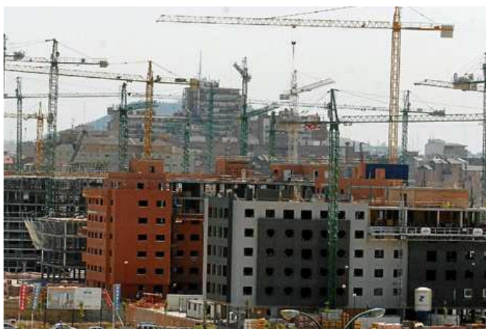
Imagen 2.2 Edificios en construcción en Valladolid Fuente: www.elmundo.es Foto: J. M. Lostau
