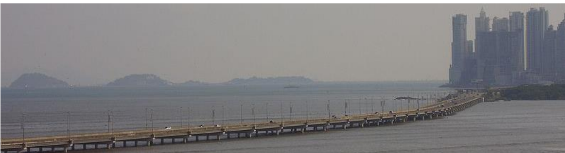
Ilustración 14: Corredor Sur a su paso por el viaducto marino cruzando la bahía de Panamá. Fuente: http://www.skyscrapercity.com
