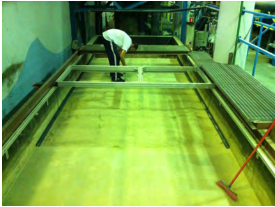
(a) Vista aguas arriba del canal.
