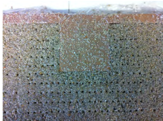
(d) Detalle de las perforaciones.
