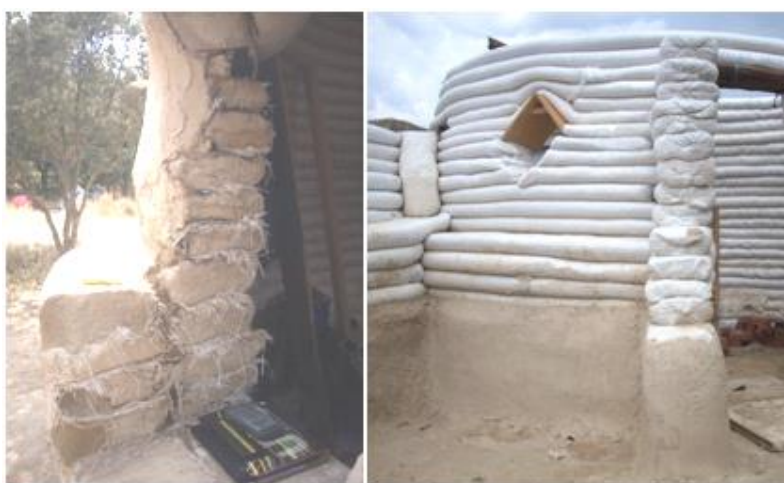
Figura 2.6 Sacos deshilachados para mayor agarre del revoco ( izquierda), sacos sin deshilachar (derecha).
