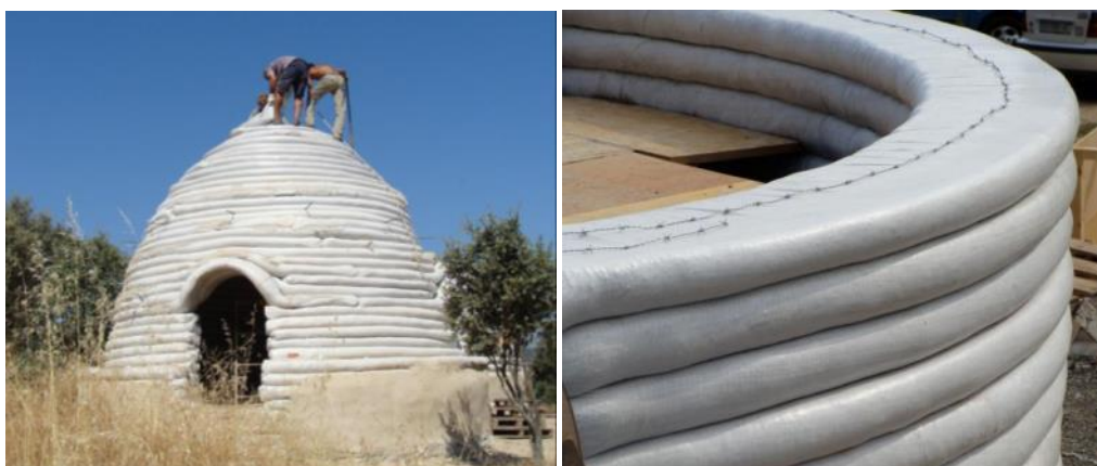
Figura 1.2 Construcción de una cúpula a base de tierra estabilizada y saco, muro cilíndrico de earthbag con alambre de espino, de izquierda a derecha.
