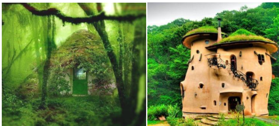
Figura 2.12 Casas de earthbag construidas con materiales del entorno.
