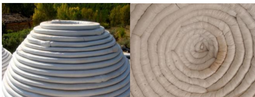
Figura 4.6 Anillos continuos en domos de superadobe.
