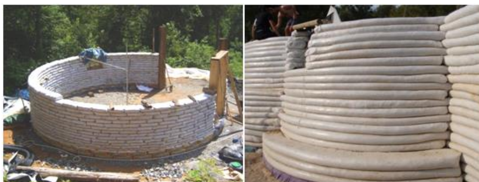
Figura 2.3 Estructuras con disposición de sacos individual (izquierda) y continua (derecha).
