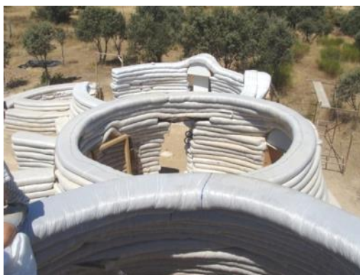
Figura 2.10 La gran anchura de los muros dificultan la transmisión del calor a través de ellos.
