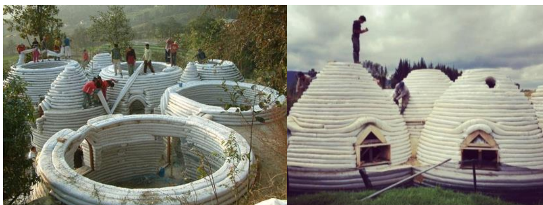
Figura 1.4 Equipo de personas en ejecución de una pequeña aldea con superadobe
