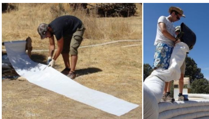
Figura 2.5 Los sacos se suministran en rollos y se cortan a medida para cada hilada. En la fase de relleno los sacos actúan de encofrado.
