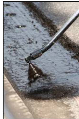
Foto 13: Vista de la minizanja tapada - Reposición de la capa superior del asfalto (Fuente: Fibra y Sistemas S.L.)
