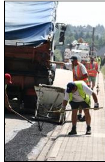
Foto 12: Relleno de la minizanja mediante mortero - Enrasado de la minizanja (Fuente: Fibra y Sistemas S.L.)
