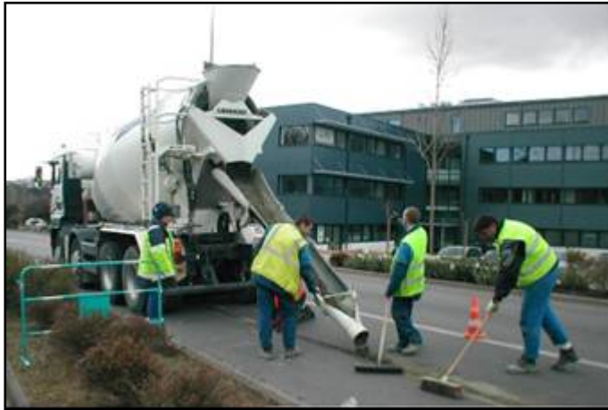
Foto 12: Relleno de la minizanja mediante mortero - Enrasado de la minizanja (Fuente: Fibra y Sistemas S.L.)
