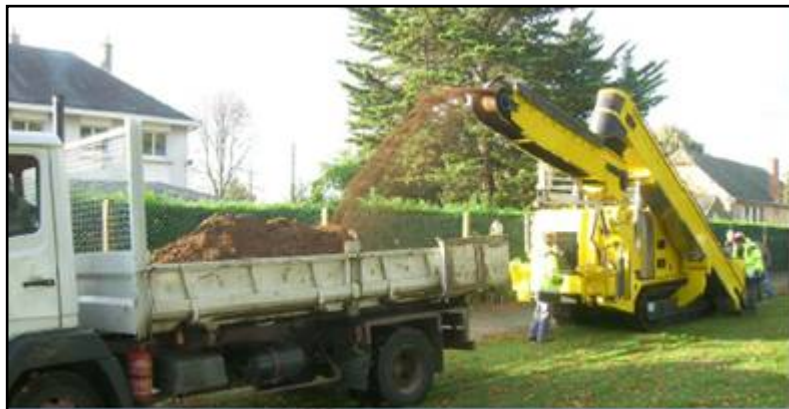
Foto 10: Retirada de la runa generada mediante cinta transportadora (Fuente: Fibra y Sistemas S.L.)
