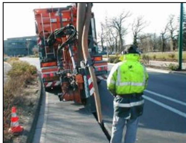
Foto 9: Realización de la minizanja - Aspirado de la runa generada (Fuente: Fibra y Sistemas S.L.)
