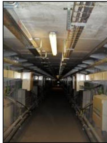
Foto 17: Ejemplo de galerías de servicios por los que discurren cables de fibra óptica (Fuente: Eva Aranda)
