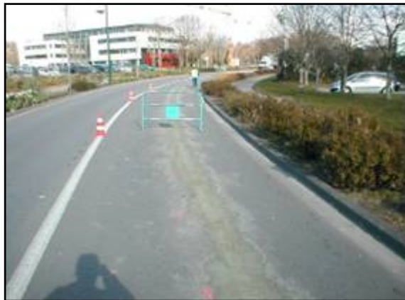
Foto 13: Vista de la minizanja tapada - Reposición de la capa superior del asfalto (Fuente: Fibra y Sistemas S.L.)
