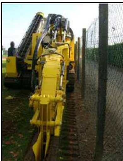
Foto 9: Realización de la minizanja - Aspirado de la runa generada (Fuente: Fibra y Sistemas S.L.)
