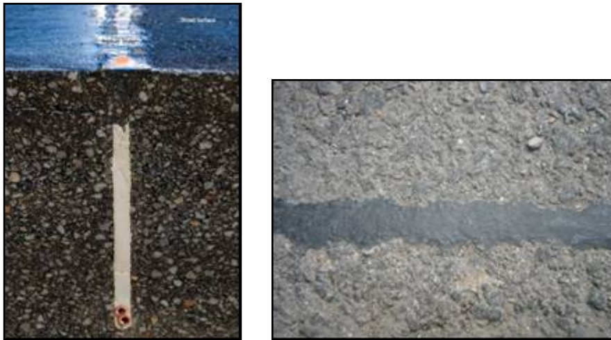
Foto 15: Esquema Vista de la microzanja – Microzanja tras reposición (Fuente: Fibra y Sistemas S.L.)
