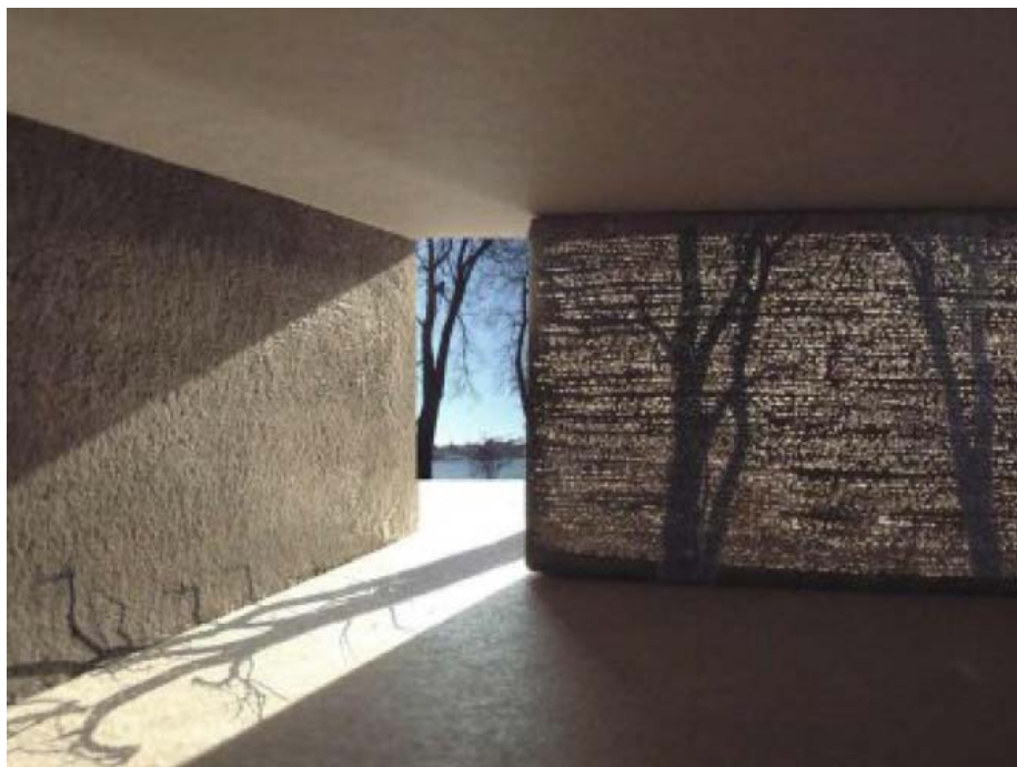
Foto 24 - Imagen de una pared de hormigón translucido (Fuente: Proyecto final de Carrera "Hormigón translucido (M a Cruz Martínez (UPV))).
