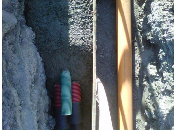
Foto 21: Canalización paralela a Gasoducto en cruce Río Cua, Cacabelos (Fuente: Eva Aranda)
