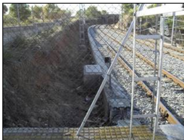
Foto 20: Canalización paralela a las vías de FGC (Fuente: Eva Aranda)
