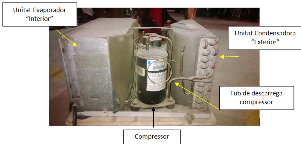
Imatge 1. Unitat Aire condicionat compacta. Vista lateral dreta.
