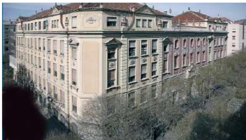
Imatge actual del Centre Públic Milà i Fontanals, antic Grup Escolar.
