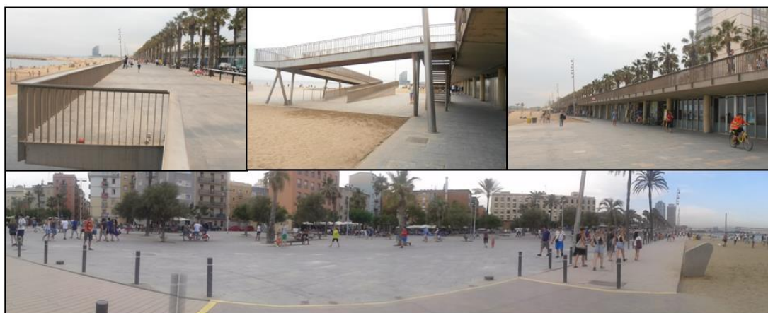
Figura 70. Fotografías propias del trasdós de las playas. Superiores: paseo marítimo Mare Nostrum elevado. Panorámica inferior: Plaça del Mar, al nivel de las playas Fuente: Fotografías propias
