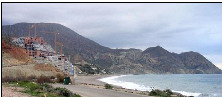
Figura 4. Construcción ilegal. Hotel en la playa de “El Algarrobico”, Almería. Fuente: “El Dominio Público Marítimo-Terrestre”. M a Carmen De Guerrero. Universidad de Zaragoza
