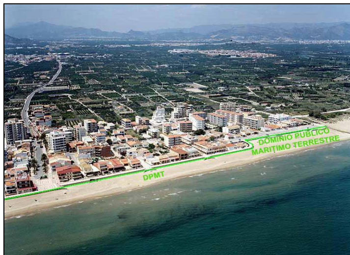
Figura 14. Tramo de costa con invasión de la servidumbre de protección
