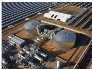
Fig. 1. Vista dels tancs de sals a la planta
