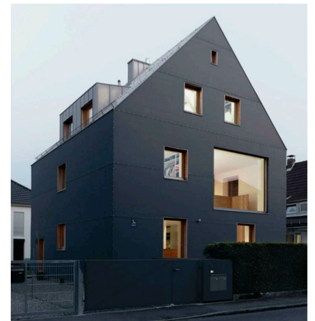
REHABILITACIÓ D'UNA CASA A LES AFORES DE MUNICH
