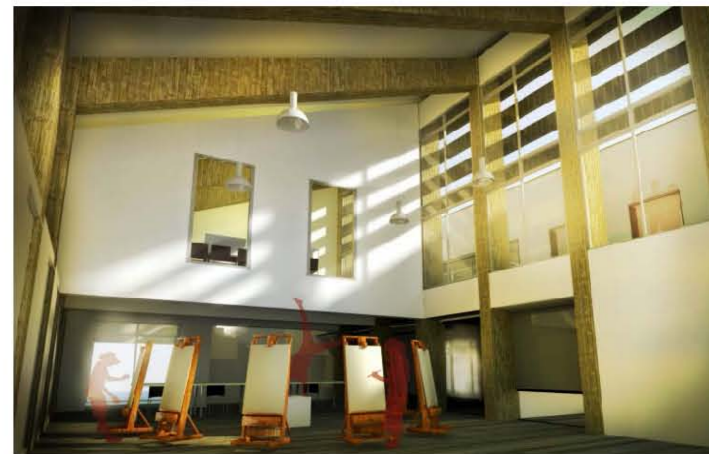
1 Grans obertures a la façana més alta del taller amb protecció solar mitjançant lames fixes horitzontals d'alumini i lames regulables mecànicament per un millor control de la entrada de llum.
