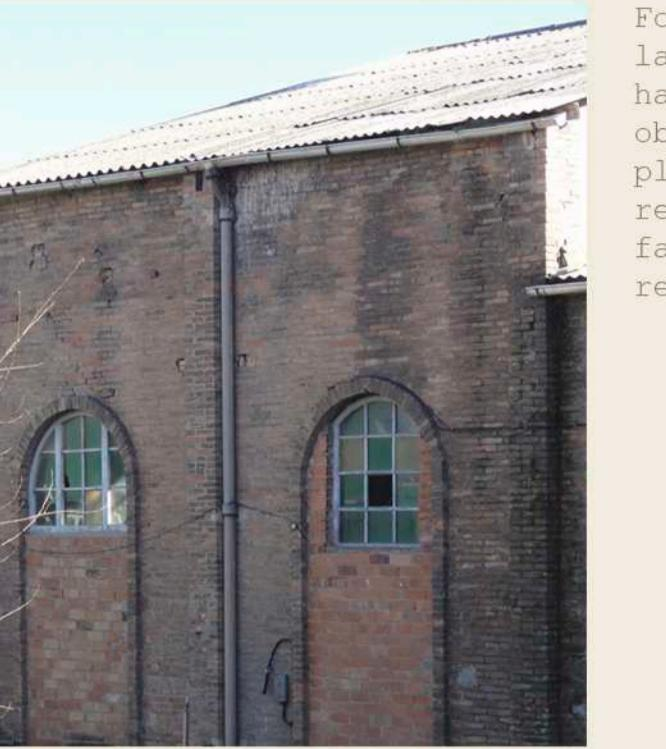
Fotografia de l'estat actual de la façana. Alguns forats que havien quedat al tancar les obertures amb vidres s'han omplert amb altres maons de diferent tamany. Actualment, la façana és un collage de diferents disposicions i maons.
