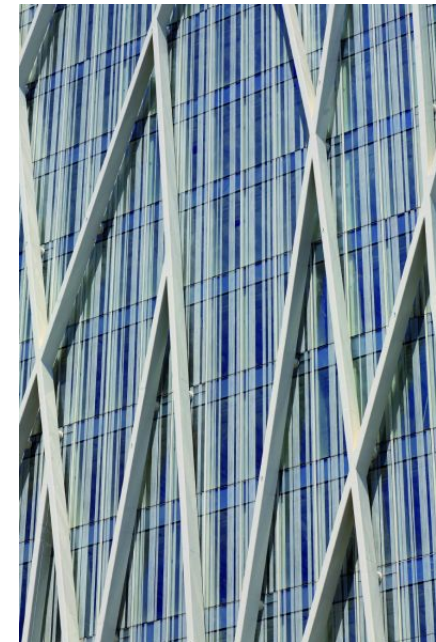
Fig. AN.12. Torre Diagonal ZeroZero, de EMBA. Se utiliza vidrio DouglassDesignextraclaro de 8 mm, Ariplak AN62 con serigrafía blanca y stralamiextraclaro 6 mm.
