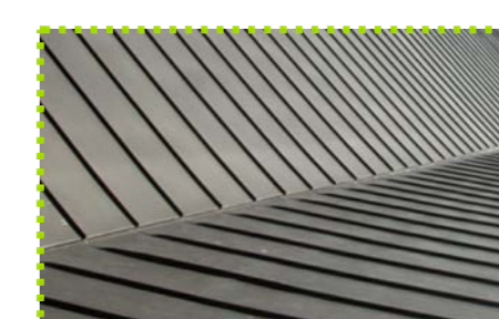
Coberta i façana de zinc amb junta alçada
