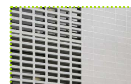
Façana de bloc de formigó i bloc de formigó buit
