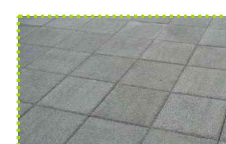
Coberta de lloses de morter permeable
