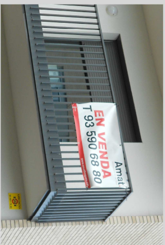
La barana es colla als laterals de la llosa per evitar problemes d'impermeabilitat.
