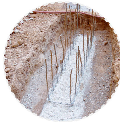
Fotografies de la posada en obra de diferents sistemes de fonamentació utilitzats fotografies n°1 i 2: sanejament de mur pantalla i biga de coronació, fotografies n°3 i 4: sanejament de pou de recalçar ja formigonat i col·locació de l'armadura de l'encepçat, fotografia n°5: armadura de mur de contenció
