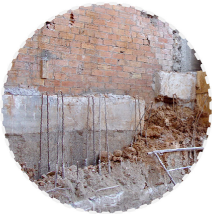
Fotografies de la posada en obra de diferents sistemes de fonamentació utilitzats fotografies n°1 i 2: sanejament de mur pantalla i biga de coronació, fotografies n°3 i 4: sanejament de pou de recalçar ja formigonat i col·locació de l'armadura de l'encepçat, fotografia n°5: armadura de mur de contenció
