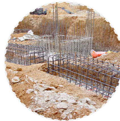
Fotografies de la posada en obra de diferents sistemes de fonamentació utilitzats fotografies n°1 i 2: sanejament de mur pantalla i biga de coronació, fotografies n°3 i 4: sanejament de pou de recalçar ja formigonat i col·locació de l'armadura de l'encepçat, fotografia n°5: armadura de mur de contenció
