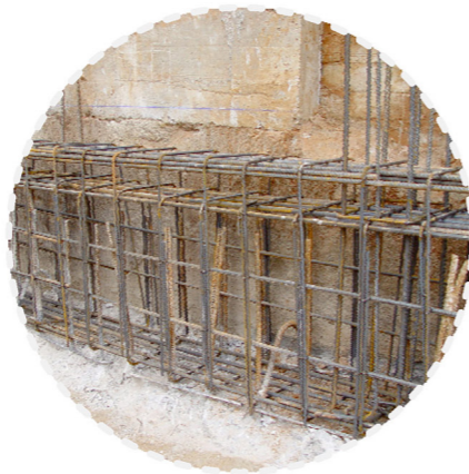
Fotografies de la posada en obra de diferents sistemes de fonamentació utilitzats fotografies n°1 i 2: sanejament de mur pantalla i biga de coronació, fotografies n°3 i 4: sanejament de pou de recalçar ja formigonat i col·locació de l'armadura de l'encepçat, fotografia n°5: armadura de mur de contenció
