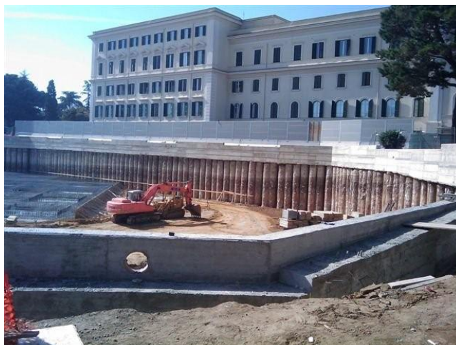
Fig. 3.1 Pantalla de pilotes.
