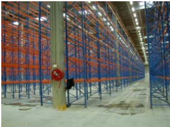
Fig. 2.11. Pavimento Ikea La Maxe (Metz, Francia) (Bekaert, 2000).
