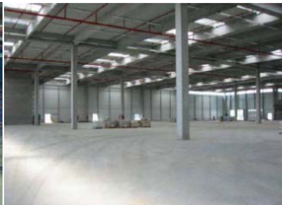
Fig. 2.12. Pavimento "Fercam" (Milán) sin juntas de retracción (Bekaert, 2004).
