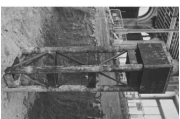
RECALÇAMENT FONAMENTACIÓ EXISTENT
