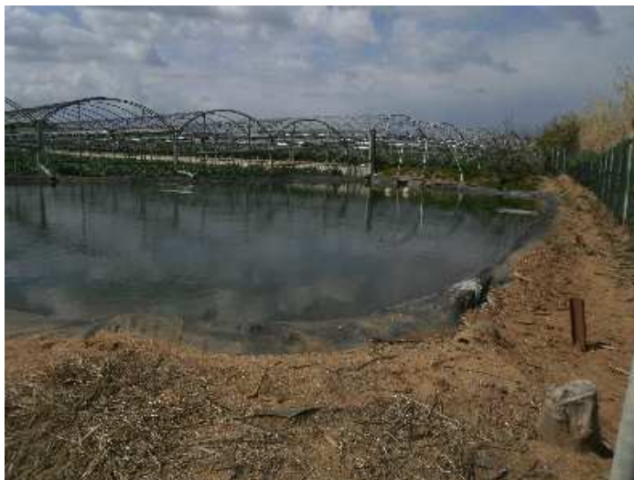
Figura 18. Bassa d'aigua de pluja de 1,5 milions de litres. (pròpia)
