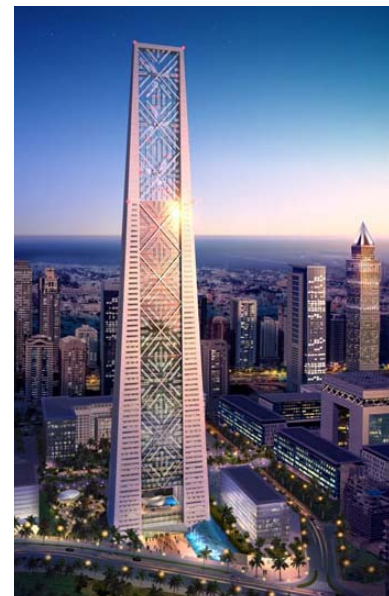
Figura 7 – Imagen del Faro de Dubai
