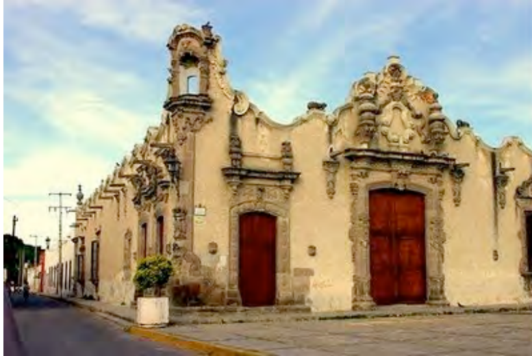
Figura 4. Fachada Principal de Casa de los Perros
