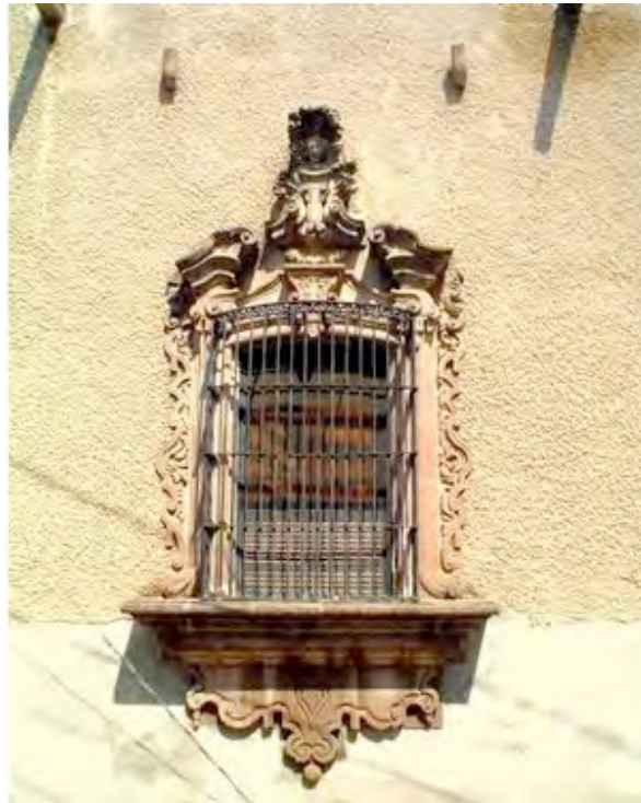
Figura 15. Ventana en fachada
