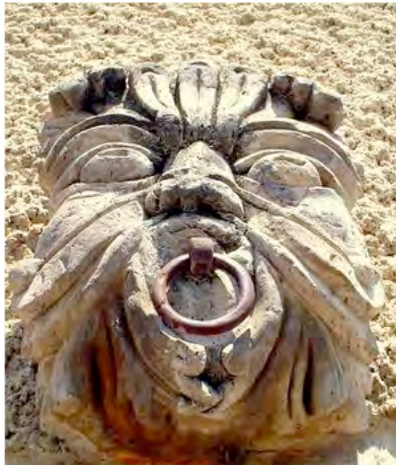
Figura 5. Detalle entrada principal
