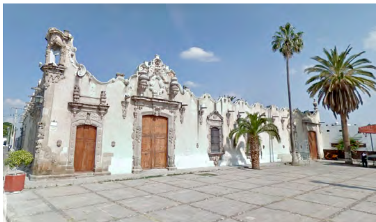
Figura 10. Fachada Principal, Plaza Juárez
