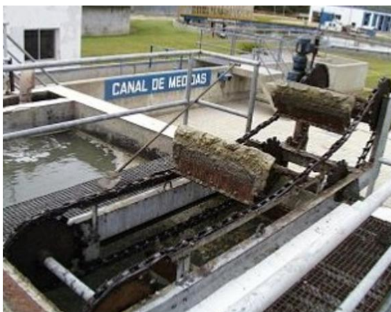
Figura 8. Desengrasador automático
