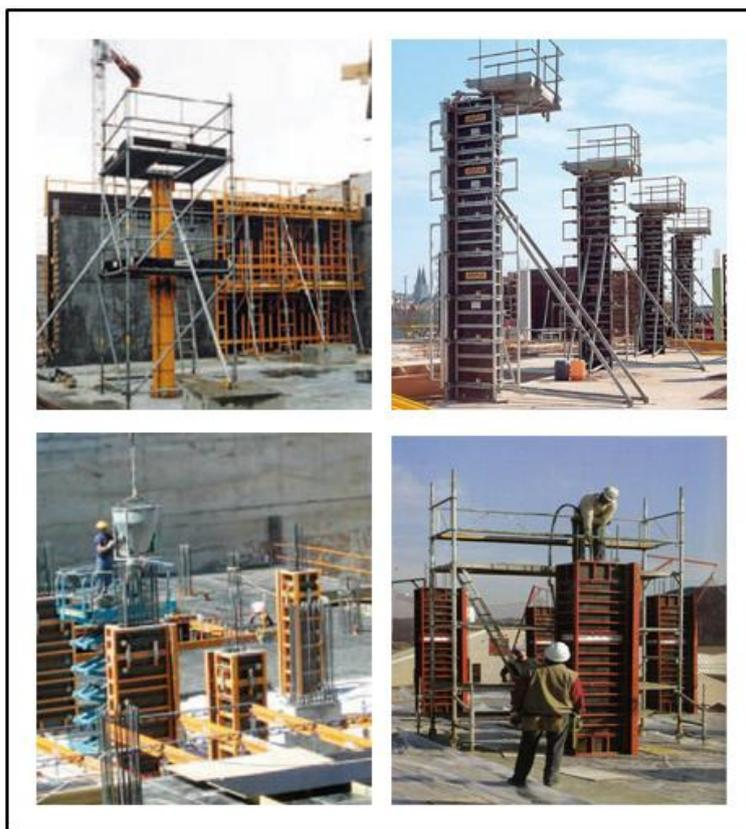
*Fig. 4.5 De izquierda a derecha, de arriba abajo: ejemplo de torre - andamio alrededor del pilar, ejemplo de hormigonado mediante plataforma elevadora, ejemplo de plataformas universales sobre encofrado y ejemplo de torre-andamio móvil utilizado para el hormigonado de pilares.*
