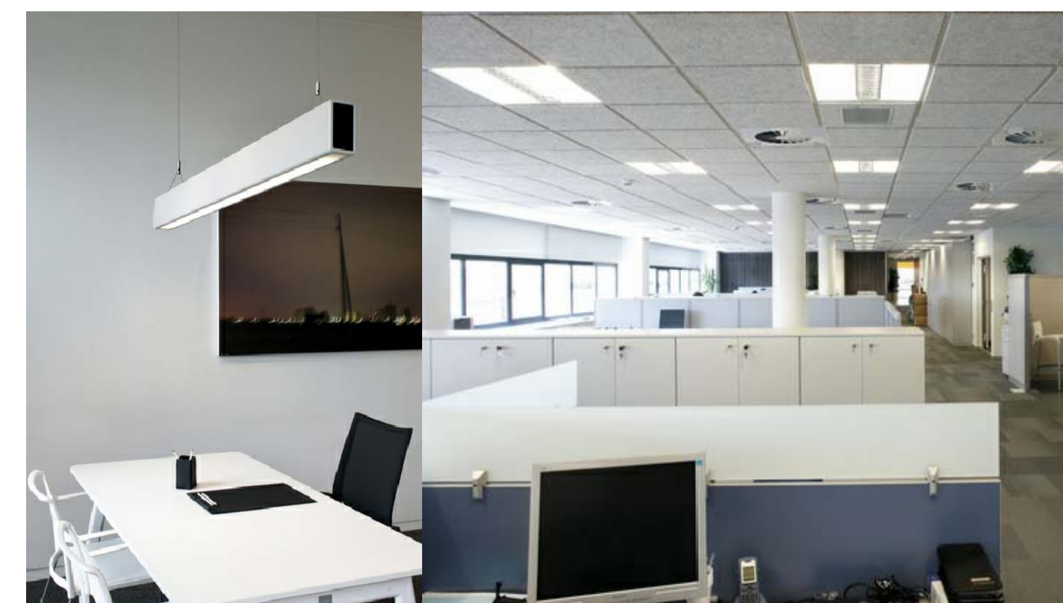
Imatge 6 Imatge 7 Àrees de treball amb ordinador: il·luminació indirecta per tal d'evitar reflexos de llum artificial a les pantalles d'ordinador (imatge 7). Àrees de prestatgeries: es disposaran llumeneres lineal (imatge 8) paral·leles a les prestatgeries, de manera que la llum banya el pla vertical i il·lumina perfectament el llocs dels llibres.
