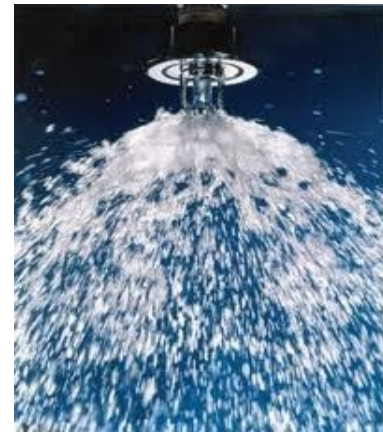
Ilustración 5: Aplicación del agua mediante rociador
