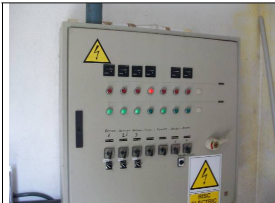
Fig 6. Detall de l'antiguitat de selectores i bombetes del quadre.
