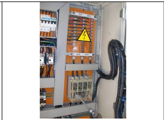
Fig 7. Seccionador molt antic.
