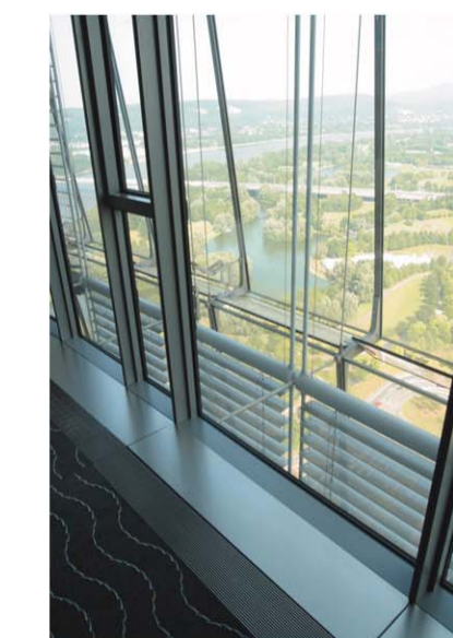
Post Tower en Bonn, Alemania. 163m. Doble fachada de vidrio practicable. Ventilación descentralizada. Combinación de ventiloconvectores en fachada y activación del núcleo de hormigón.
