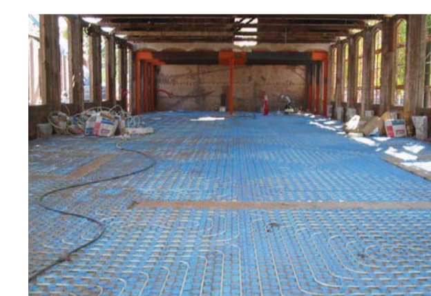
Exemple d'instal·lació de terra radiant
