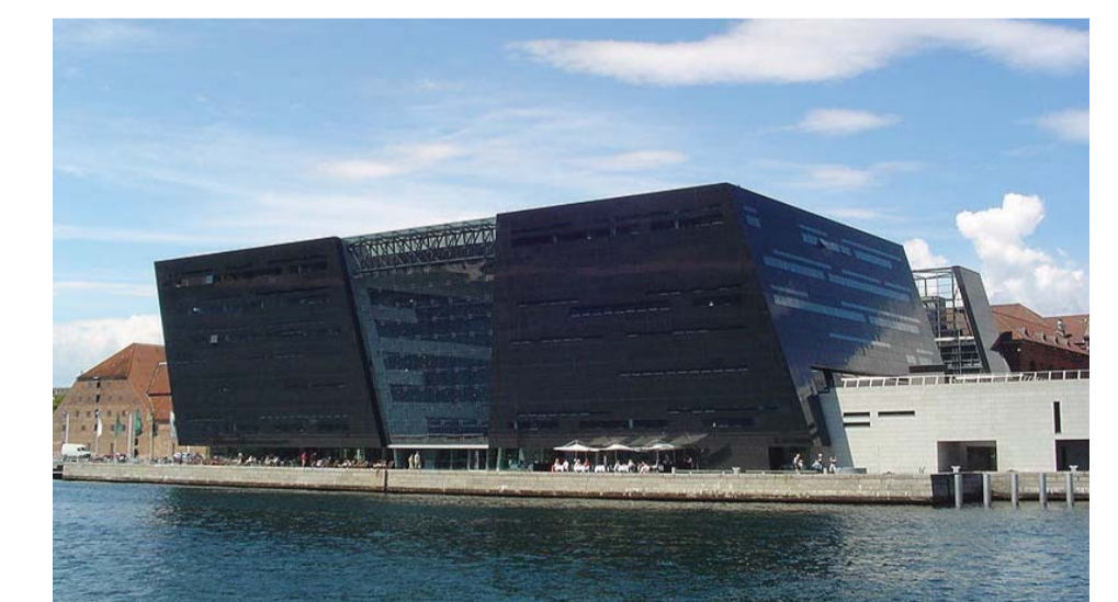
Royal Library Copenhagen, Schmidt Hammer Lassen, 1999, 20.733 m 2 (extensió), població 530.902
