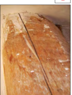
Atac de corcs en l'encastrament de la biga 8, sala Sud-oest Planta Sotacob.
