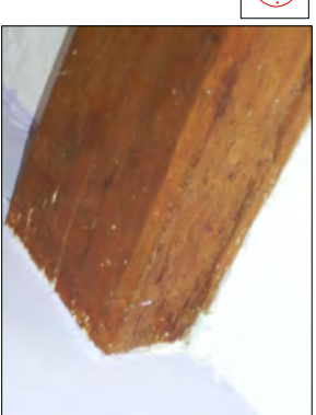
Atacs de corcs en l'encastament biga 5 sala d'audiovisuals Planta Primera.
