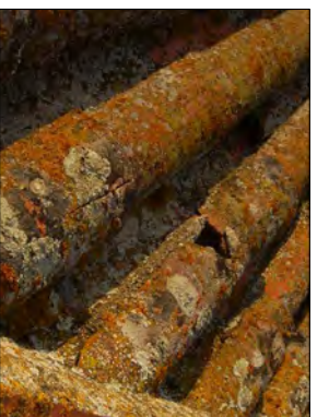
Trencament de teules i fissures en tota la coberta inclinada.
