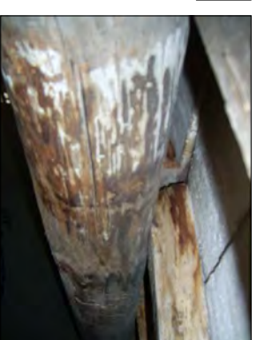
Fongs de podrintent en la biga 12 sala central Planta Sotacoberta.
