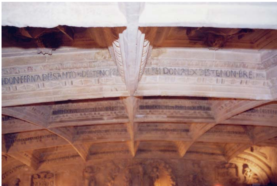
Figura 16. Veladura original de consolidación, protección y entonación cromática
