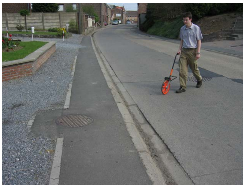
Mesurage de distance entre taques avec la roulette
