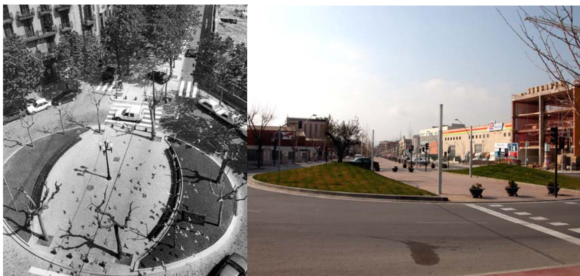
Fig. 6.6: Rotonda típica en paseo peatonal, a la izquierda en la Rambla del Poblenou (Barcelona) y a la derecha en la Avinguda del Ferrocarril (Terrassa).
