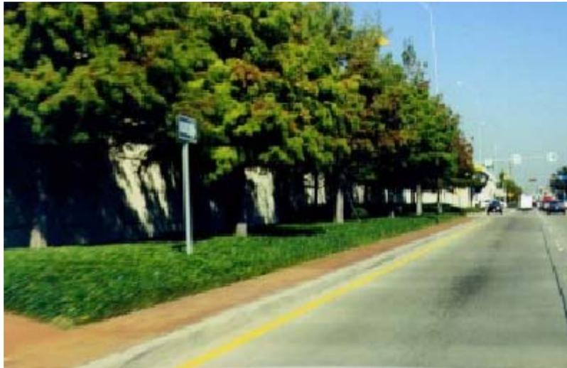
Fig. 4.52. La vegetación es efectiva para minimizar la altura de los muros o barreras sónicas.
