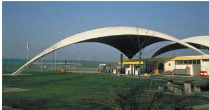
Fig. 4.16. Gasolinera BP, Deiting, 1968, Heinz Isler. Cubierta esférica apoyada en tres puntos y abierta, hormigón armado de mínimo espesor.
