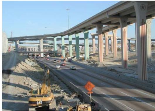
Fig. 7.12. High Five en Dallas, construcción 2003. La tipología de puente de elementos lineales prefabricados resuelve todos los problemas con eficacia menos el estético, la pintura y textura en los pilares identifican la región.
