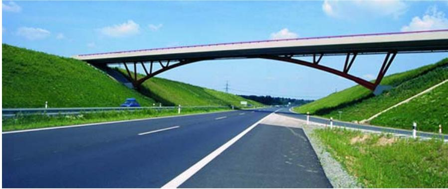
Fig. 4.74. Puente en la República Checa. Estribos enrasados al talud.
