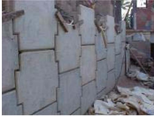
Fig. 4.44. Muro de tierra armada con escamas.
