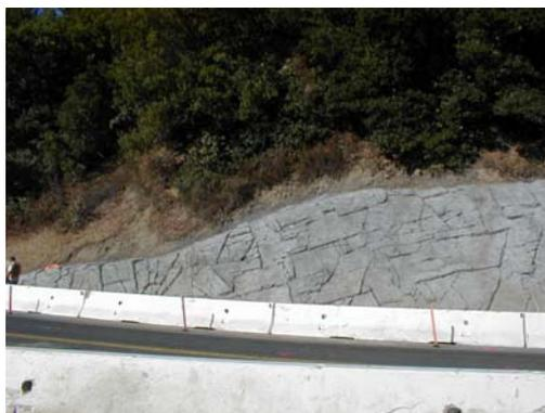
Fig. 4.48. Muro de hormigón armado con acabado superficial.
