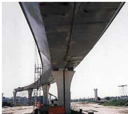
Fig. 4.70. Autovía del Baix Llobregat. Las pilas tienen una línea vertical claramente definida por medio de rehundido y color que las hace parecer más altas y por ello más esbeltas.
