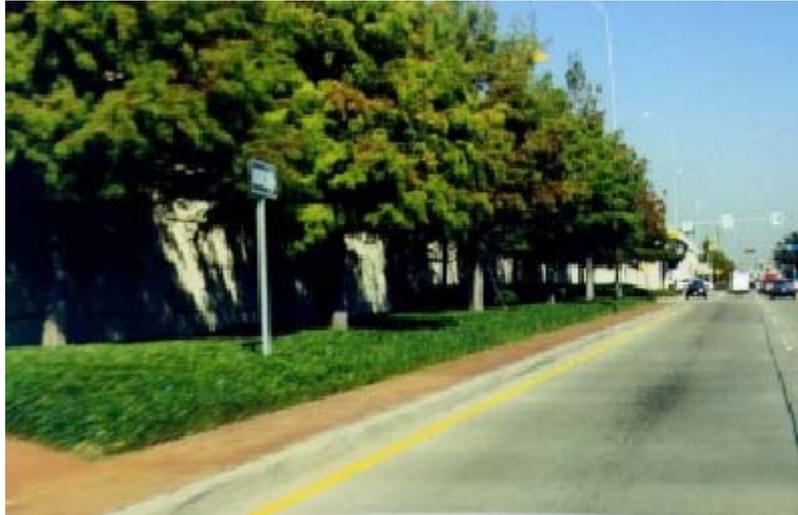
Fig. 5.9. La vegetación es efectiva para minimizar la altura de los muros o barreras sónicas.
