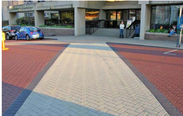
Fig. 4.37. Pavimento de asfalto impreso y coloreado.
