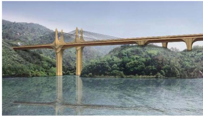
Fig. 4.88. Es un puente de hormigón atirantado de pretensado extradadosado.
