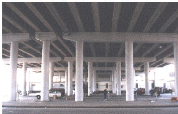
Fig. 4.76. La solución de vigas simplemente apoyadas en dinteles sobre pilares es económica pero inaceptable estéticamente.
