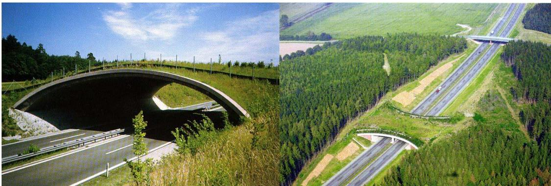
Fig. 4.91. Puente Verde en Alemania, *amphibian crossing*.
