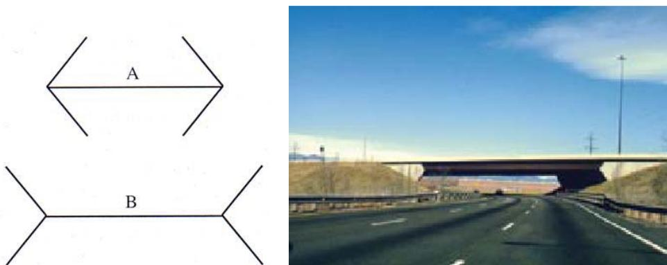
Fig. 4.69. La línea B parece más larga que la A. El paso superior, con los estribos inclinados parece más largo, luego el tablero parece más esbelto.
