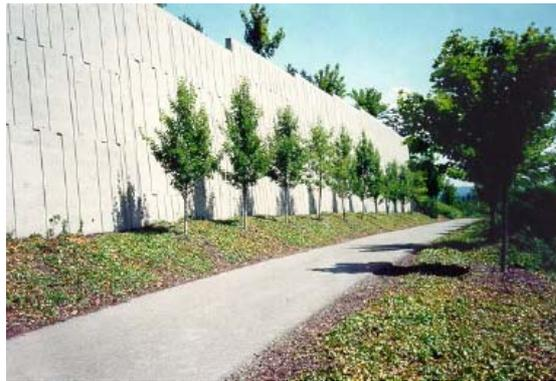
Fig. 4.46. Los muros prefabricados suelen estar compuestos por elementos planos.
