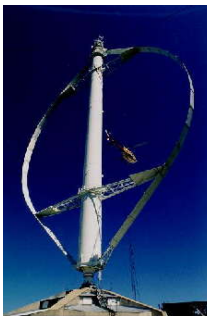
Figura 5. Aerogenerador eje vertical.
