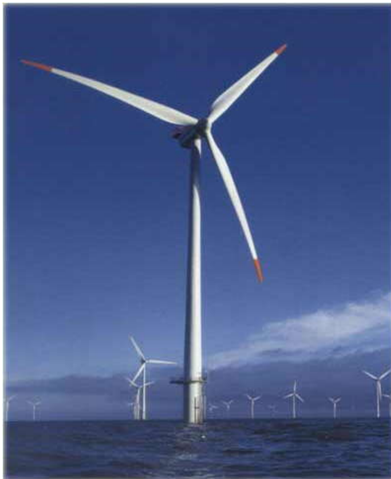
Figura 1. Aerogenerador eje horizontal.
