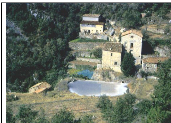
F.13 Viviendas y balsa del agua dulce, de donde partían las canalizaciones para los molinos 13
